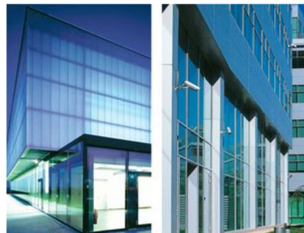
QuadroClad med honeycomb konstruktion, der oprindeligt er udviklet til flyindustrien, kombinerer lav vægt med ekstrem styrke. Facadebeklædningen fungerer som en selvdrænende regnskærm og er en såkaldt ventileret konstruktion. Læs mere
