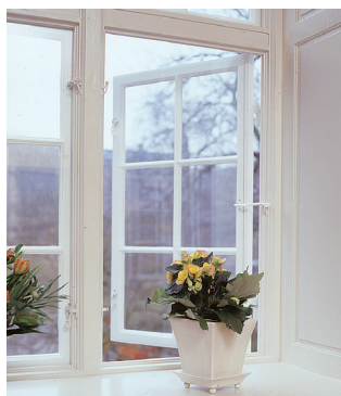
Vinduet åbnes uden rydning af karm.
