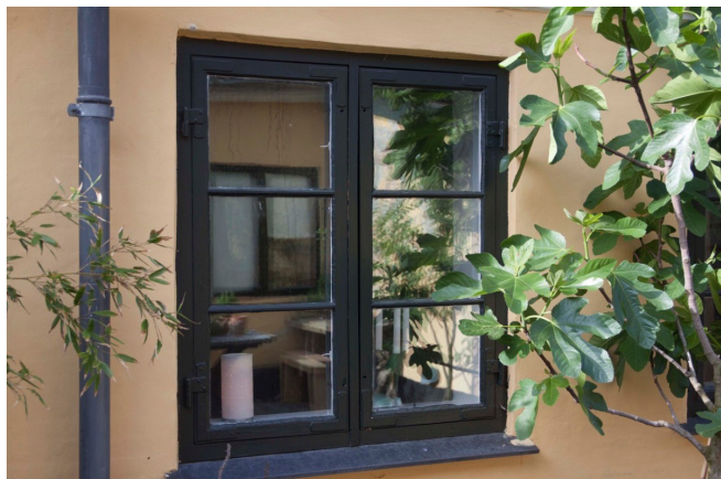
I Dragør har man en lokalplan der stiller særlige krav til vinduerne. Ejeren valgte at bevare de gamle vinduer og montere Optoglas for at opnå bedre isolering og indeklima.
